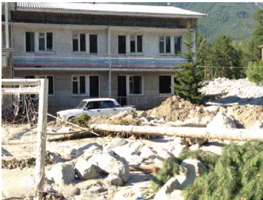
Рис. 1. Разрушения в поселке Аршан
